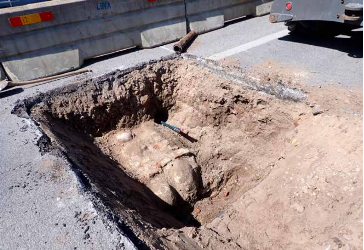
Figur 4. Rester av strandmuren i schakt 2. Foto mot NV. Foto Patrik Hallberg.
