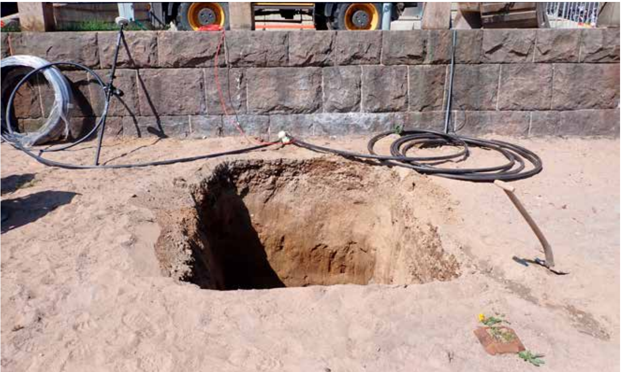
Figur 5. Schakt 4 nedre hamnplan med sandfyllning. Foto mot V. Foto Patrik Hallberg
