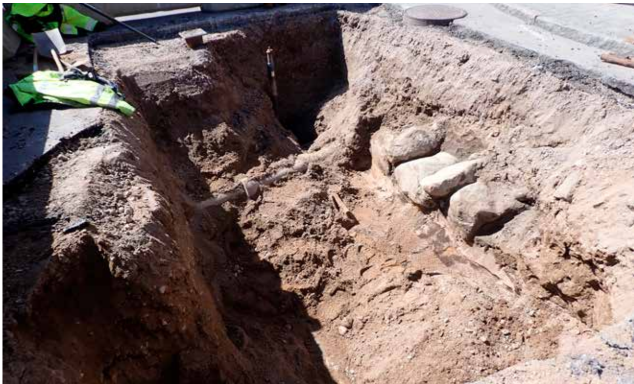
Figur 3. Frilagd stenläggning i schakt 1, samt vattenledningar. Foto mot SV. Foto Patrik Hallberg
